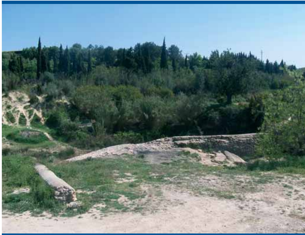
Dique de El Clot de la Gramassada (Picassent)
