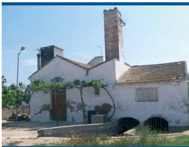
Motor del Progreso (Silla)
